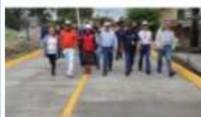
Pavimentación de Calles
